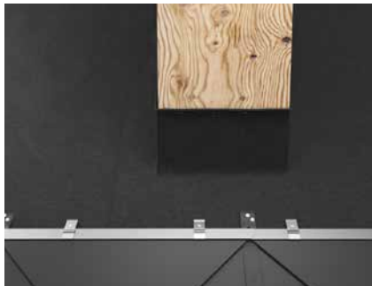
Illustration 111 • Tagluge – særligt forhold i forbindelse med tagrombe 29 × 29 og 44 × 44
