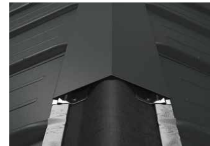
Illustration 73 • Rygningsdesign med enkel rygningsskappe
